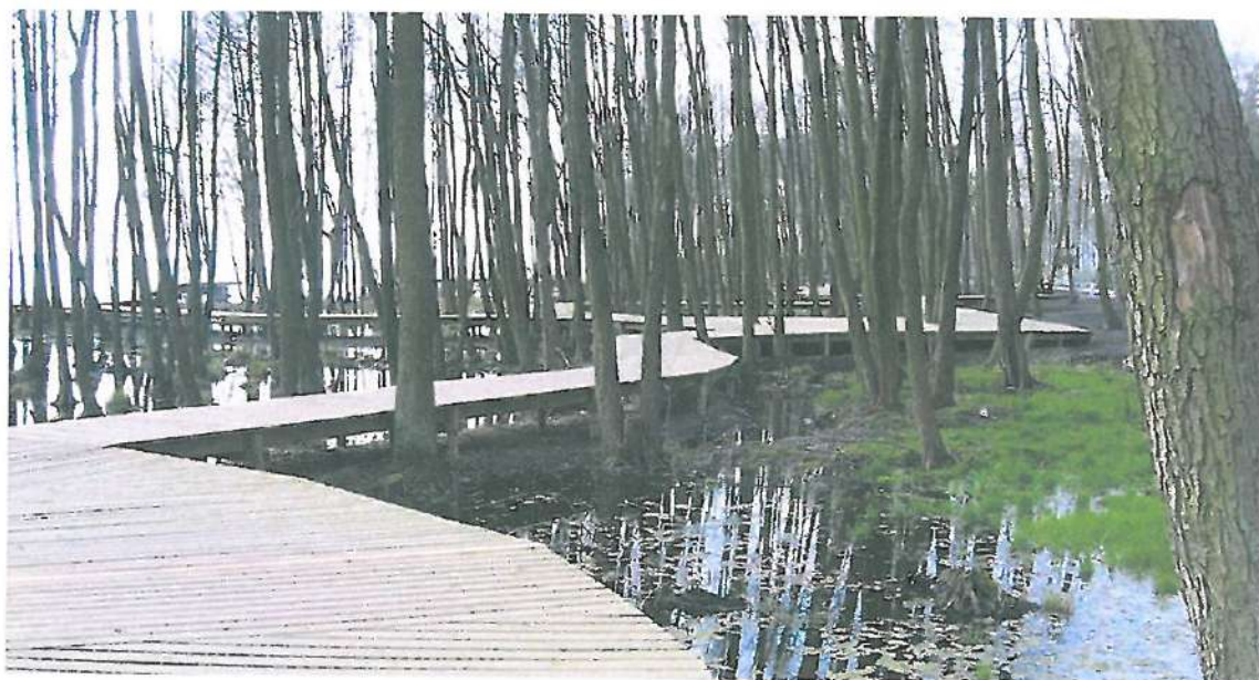
Ryc. 5: przykład podobnej realizacji - aleje z elementów drewnianych na terenie podmokłym, wyniesione ponad poziom terenu, montowane kształtowane swobodnie pomiędzy drzewami.
